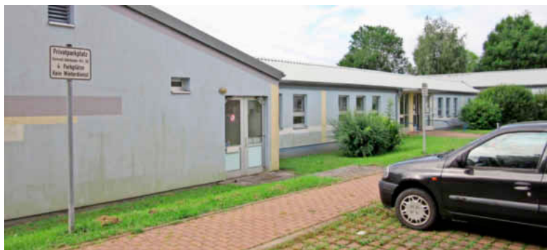
Ein Großteil der Wohnungen in der Konrad-Adenauer-Straße 11 soll barrierefrei werden. Bisher wurde das Gebäude von Firmen für Schulungszwecke genutzt.
